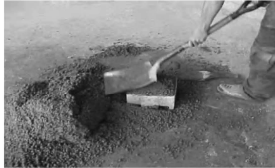
Fig. 9 Llenado y "compactación inicial."
