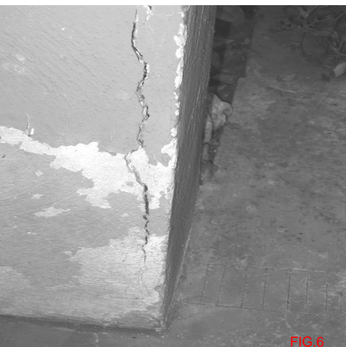
Figura. 4 Daño en estructura por corrosión de acero de refuerzo.
