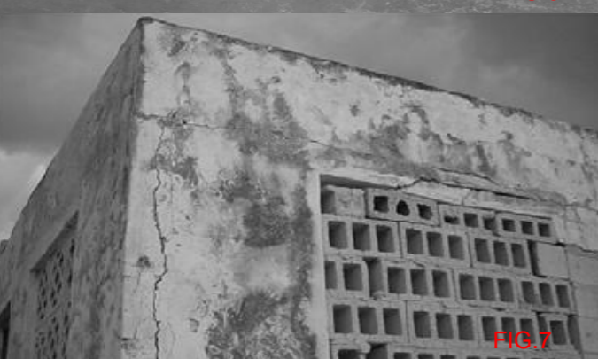
Figura. 7. Condiciones inseguras causadas por la corrosión del armado de refuerzo.
