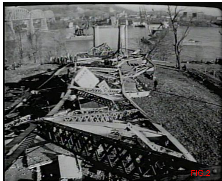
Figuras 1-3 Vistas del colapso del puente Silver, sobre el río Ohio por defecto de fabricación y el tiempo.
