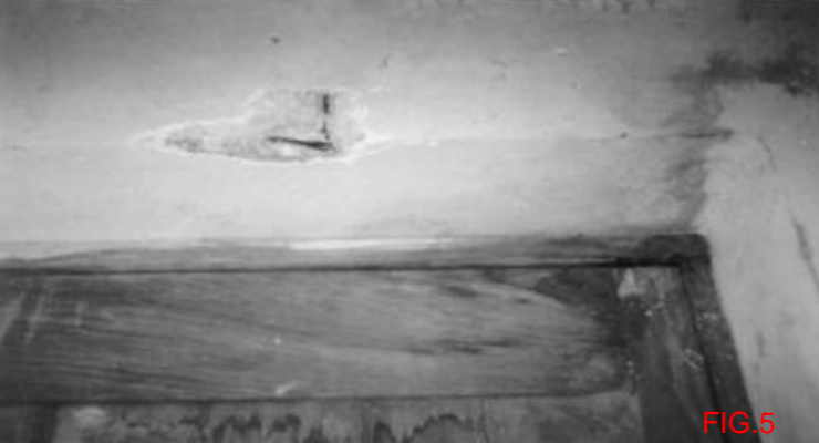
Figura. 4 Daño en estructura por corrosión de acero de refuerzo.
