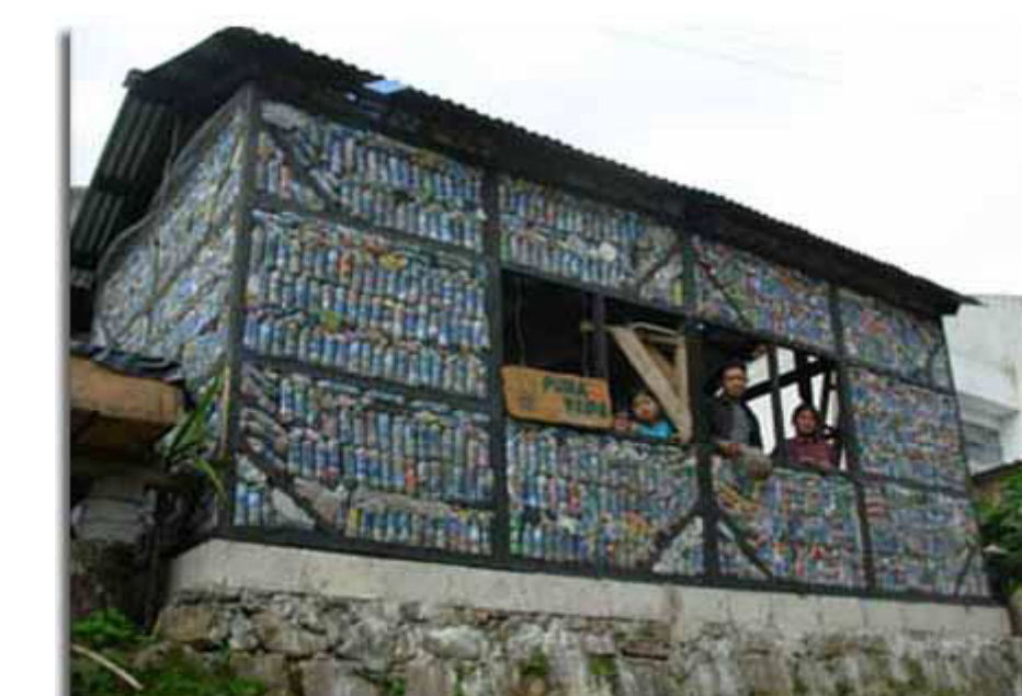
Construcción a partir de botellas de plástico
