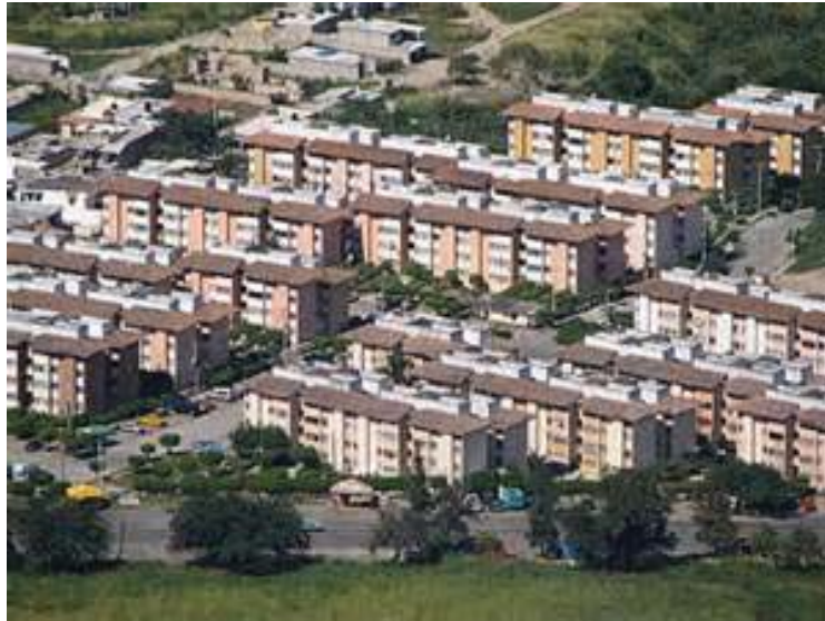
Panorámica de unidad habitacional
