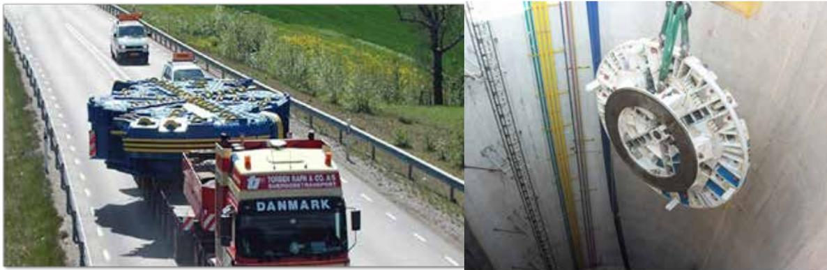
Figura 2. Traslado de rueda de corte por carretera (izq.) y su descenso a piso de lumbrera (der.)
