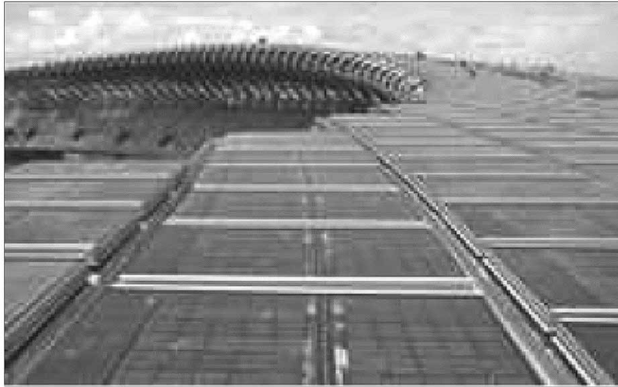
Figura 27. Recolección de agua de lluvia.
