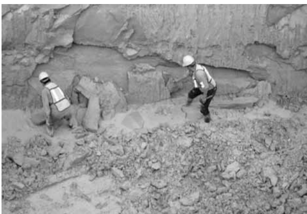
Fig. 5: Excavaciones en las que no se cumplen las medidas de seguridad y se presentan derrumbes
