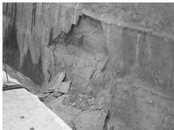
Fig. 5: Excavaciones en las que no se cumplen las medidas de seguridad y se presentan derrumbes
