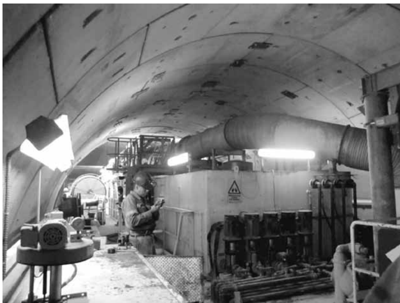
Fig. 6: Trabajos en espacio confinado
