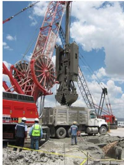
*Fig. 4. Excavación para muros Milán*
