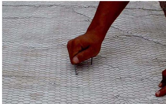
Colocación de grapas para evitar deslizamientos de la malla
