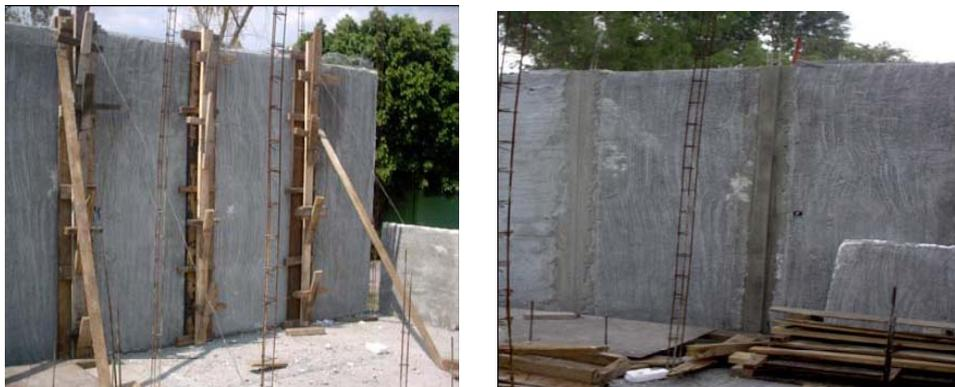
Colado de los castillos con los Paneles de Ferrocemento
