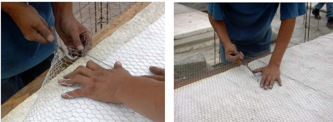
Tensado de la malla sobre el panel
