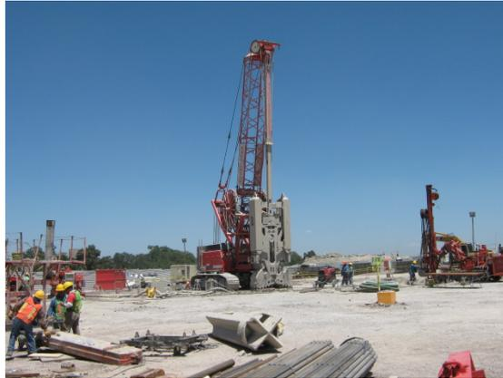
*Fig. 3. Realización de muro Milán*
