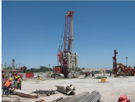
Fig. 3. Realización de muro Milán
