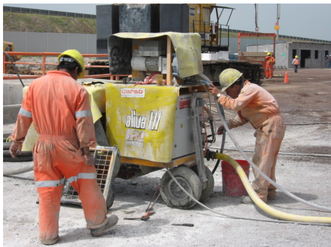
Fig.5. Máquina utilizada para lanzar concreto (Aliva)
