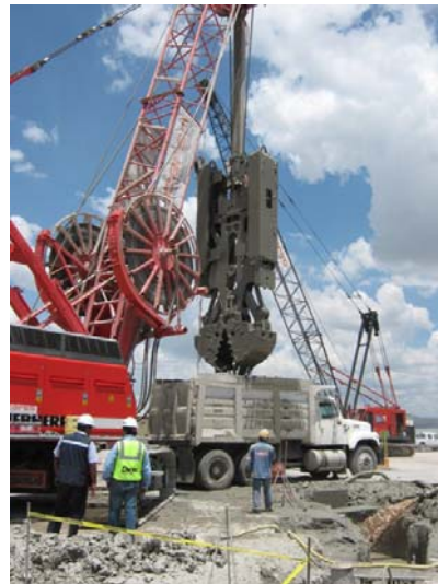
Fig. 4. Excavación para muros Milán
