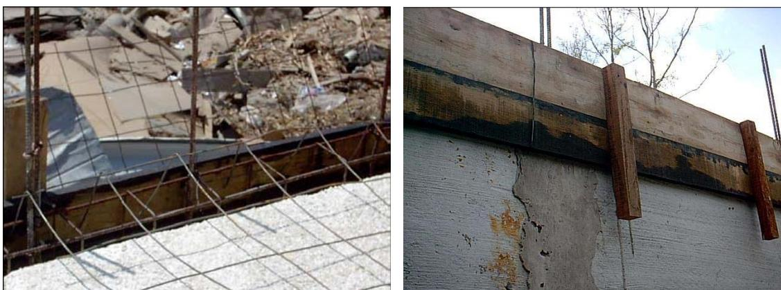
De manera planeada se van colocando las viguetas donde se colocara la bovedilla (poliestireno), se va colocando en esté caso el poliducto que alojara el cableado de las instalaciones eléctricas y posteriormente se hará el colado del firme de la losa que aproximadamente es de 5cm. Tal como se ilustra en las siguientes fotografías.
