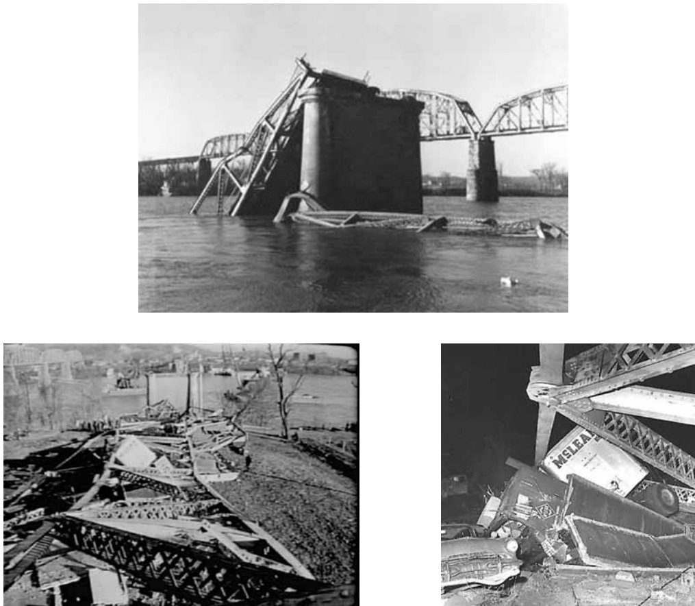
Figuras 2 a 4. Vistas del colapso del puente Silver, sobre el río Ohio por defecto de fabricación y el tiempo.
