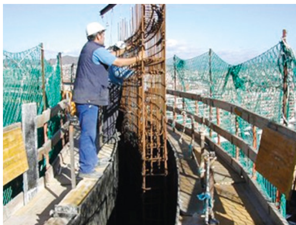
Figura 3. Colocación de armado de acero para muro exterior
