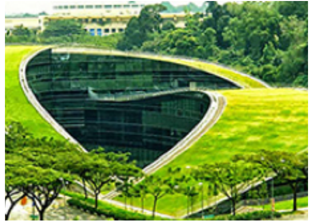
Imagen 1. Un tratamiento de cubiertas completamente verde fue la estrategia implementada para el edificio del School of Art and Media de la Universidad Tecnológica de Nanyang en Singapur. Foto: Cortesía de Imágenes Google.
