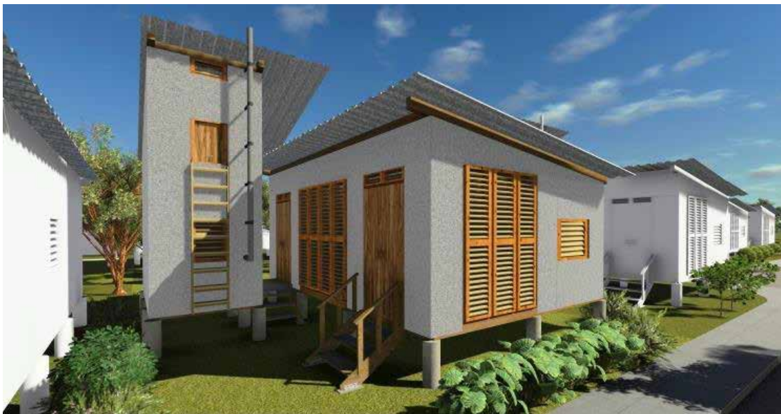
Figura 11. Vista frontal de vivienda.
