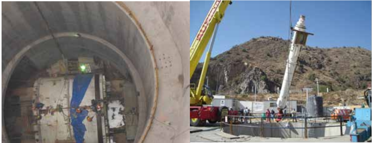
Figura 3. Vista en planta del escudo ya en piso de lumbrera (izq.) y descenso de tornillo sin fin (der.)
