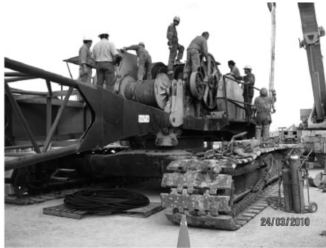
Fig. 2 Montaje de grúa con capacidad para 250 toneladas.
