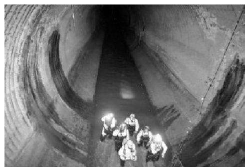
Imagen del drenaje profundo. 16
