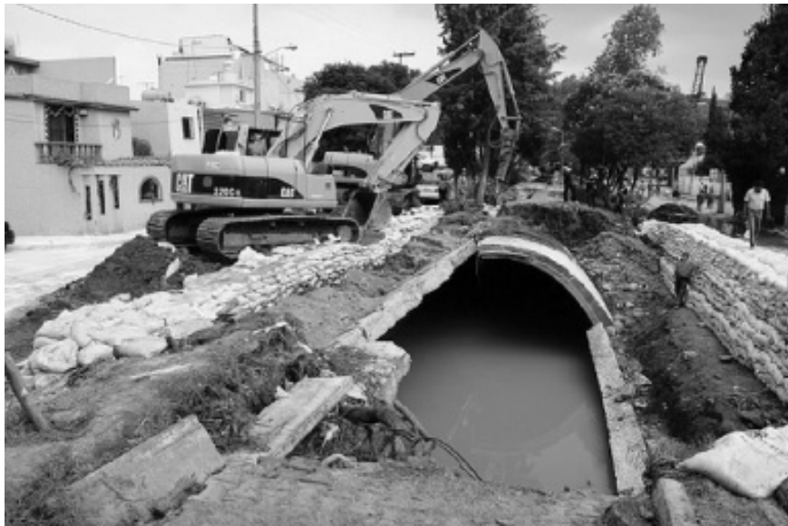
Imagen del Drenaje profundo Reventado en Valle Dorado Tlalnepantla Edo de México.
