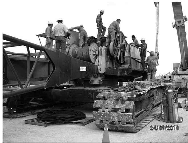
Fig. 2 Montaje de grúa con capacidad para 250 toneladas.
