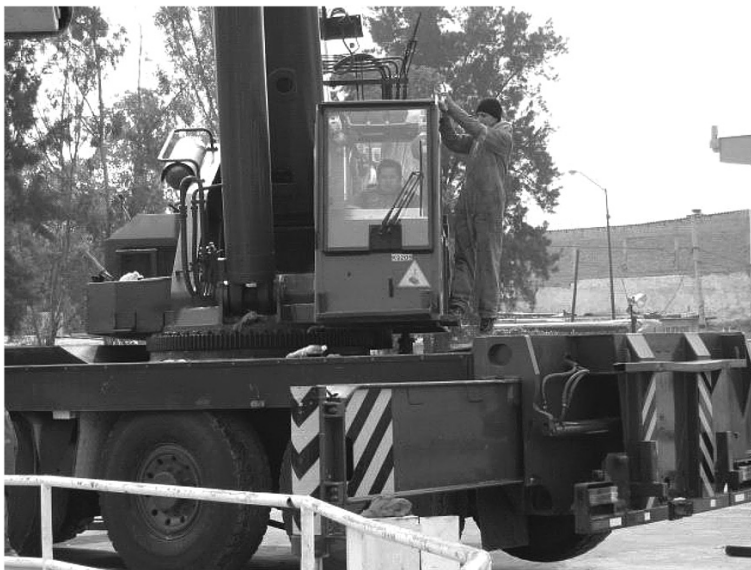
Fig. 1 Actos imprudenciales que ponen en riesgo la integridad física.
