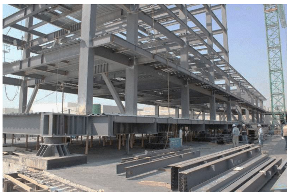
Imagen 12: Plaza Vía Vallejo en etapa de construcción Fuente: MAGEBA
