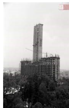
Imagen 8: WTC México en etapa de construcción en el año de 1970 Fuente: https://tinyurl.com/3myr2hy9 Fecha de consulta: diciembre 2022
