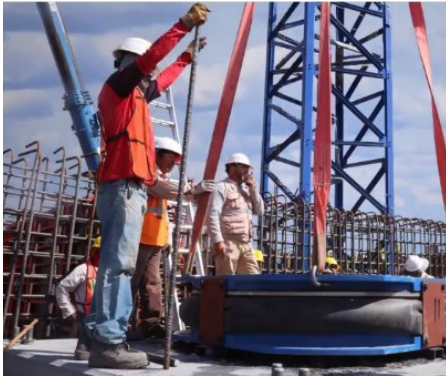
Imagen 16: Aislador basal EPS Fuente: https://tinyurl.com/2ua6rdys Fecha de consulta diciembre 2022
