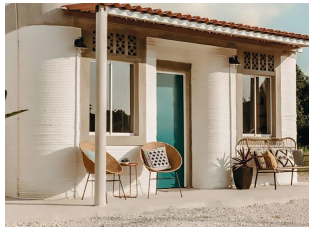
Figura 9. Casa impresa en 3D para una comunidad del municipio de Nacajuca, Tabasco. Fuente: New Story, 2019.
