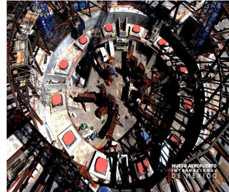
Imagen 17: Construcción NAICM año 2019 Fuente: https://tinyurl.com/2ua6rdys Fecha de consulta diciembre 2022
