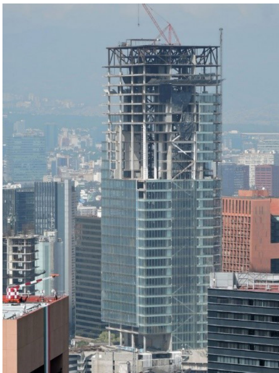
Imagen 9: Torre Cuarzo en etapa de construcción 2015 Fuente: QUAKETEK
