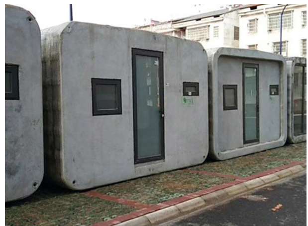
Figura 5. Salas de aislamiento construidas en 3D, para personas contagiadas de COVID-19 en China. Fuente: Boissonneault, 2020.
